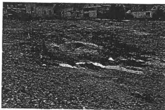
*Bei der Bauaufreimung stark verdichteter Boden mit tiefen Fahrspuren. Hier wurde keine Vorsorge betrieben.
