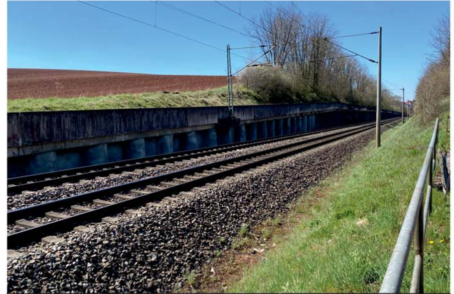
Zugstrecke südöstlich der Planfläche
